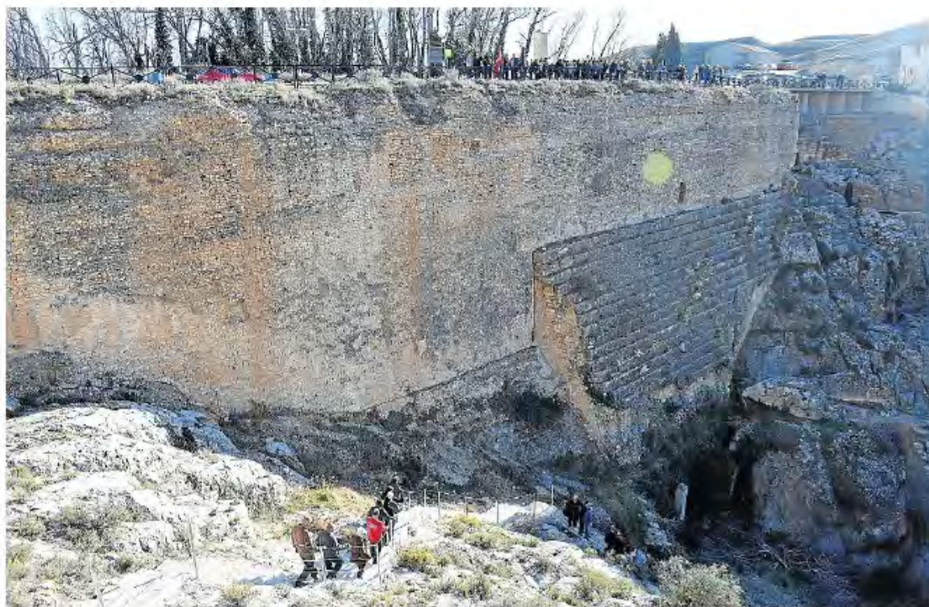
Los vecinos de Almonacid descendieron por la escalera hasta llegar a la compuerta. C. GARCÍA TEJEDOR
